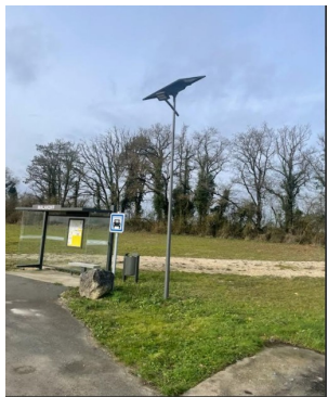
Ajout éclairage public Malakoff
