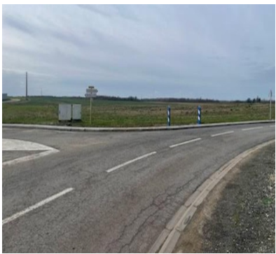
Nouveau carrefour à Villiers
